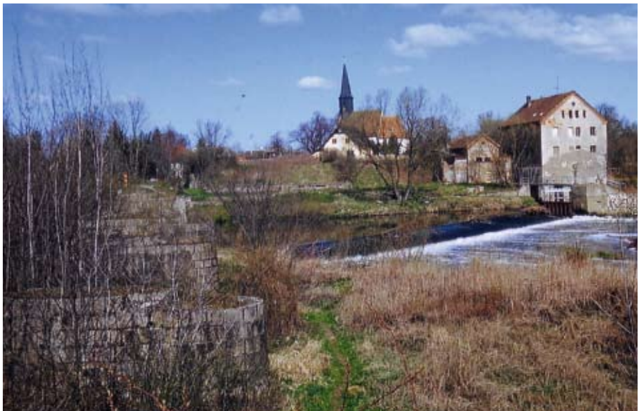
Die Stümpfe der Weißeritzbrücke nach der Sprengung vom 7. Mai 1945 (2007)
