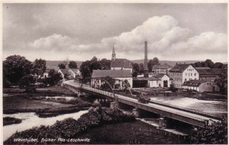
Die Weißeritzbrücke von 1883 (1940)
